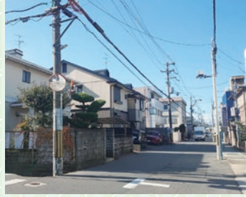
⑨古室3丁目 グロリア魔法瓶 セブンイレブン前 街路灯3機設置
