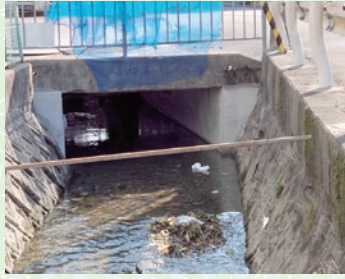
③大井5丁目27付近 橋の下部の改修
