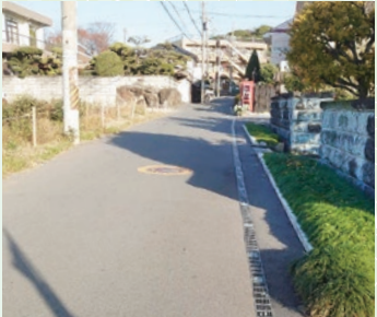
⑪古室 側溝の整備
