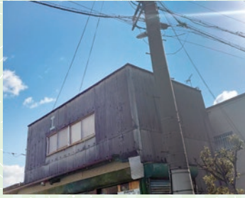
②大井5丁目 白江建材前 街路灯の設置
