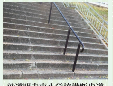
㉑道明寺東小学校横断歩道 下の階段の手すり設置
