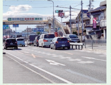
⑤西古室交差点 右折レーン設置
