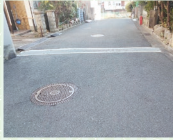
④沢田4丁目 側溝の安定を確保
