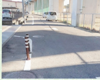
⑧古室3丁目 衝突防止のポストコーン設置
