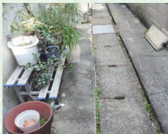
⑲船橋町4丁目 溝蓋補修
